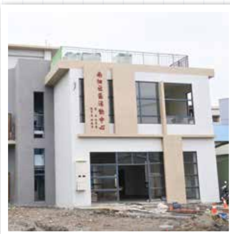
▲南佃社區活動中心即將完工
